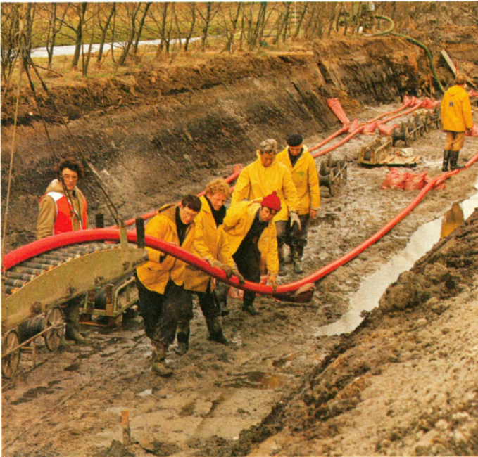
Fase de enterramiento de un cable conductor coaxial. Se procura que el cable no quede retorcido y apoyado en una base firme que no sufra deformaciones.
