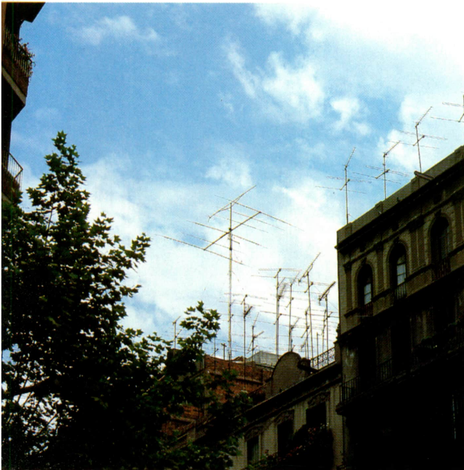
De entre el bosque de antenas de TV (UHF-VHF) sobresale una antena direccional de HF para la banda de la radioafición.
