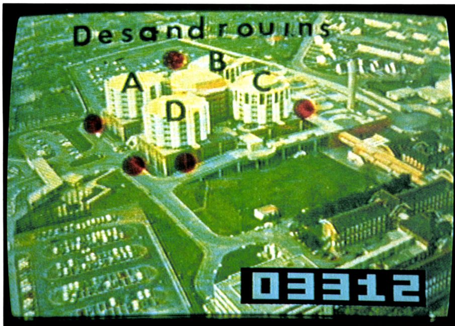
Vue aérienne sur vidéo-disque (en rouge, les points d'eau).
